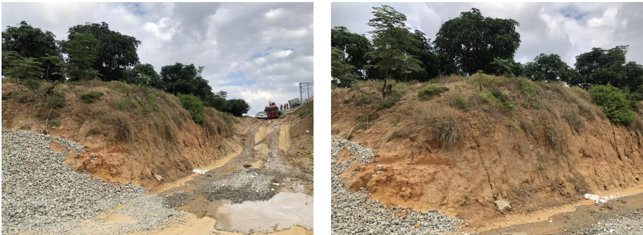
照片 71~72 在建镇海站东侧 BT3 现状
