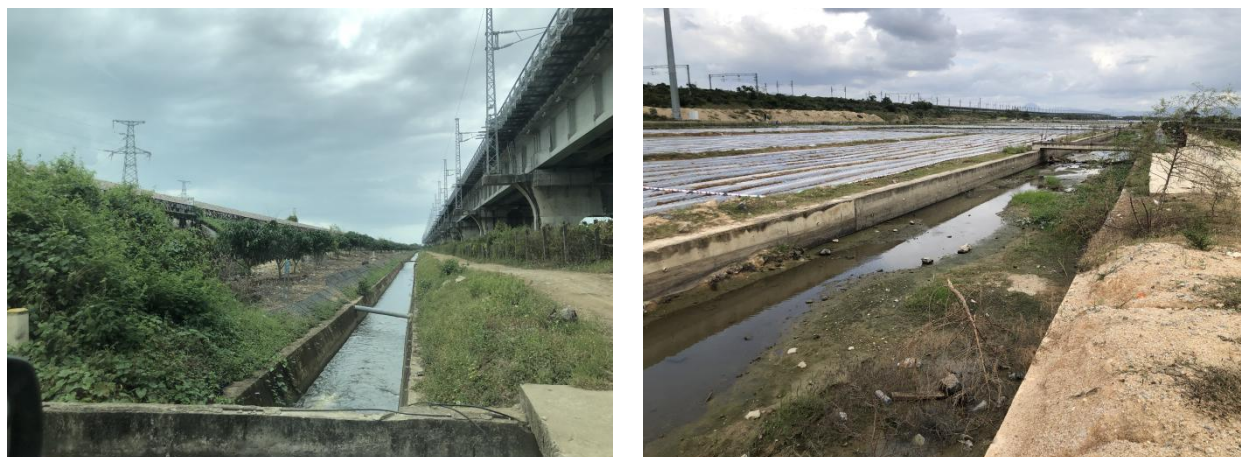
照片 35~36 评估区北部灌溉引水渠现状照片
