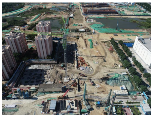
照片 54 中心渔港片区路网建设
