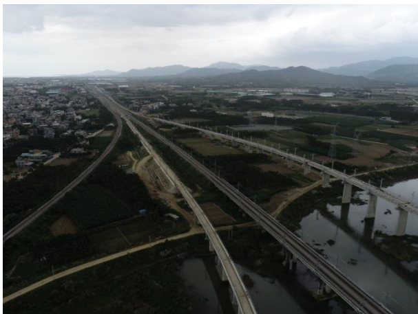
照片 51 评估区内西环铁路建设
