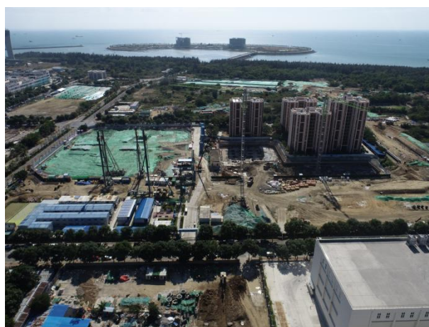
照片 50 中心渔港保障性住房建设
